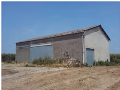
BÂTIMENT DE FORAGE.
