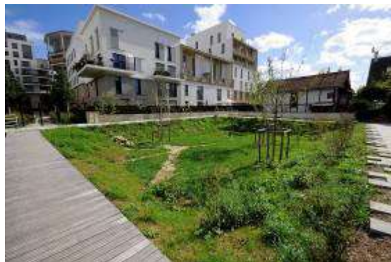
A Nanterre, près de Paris, un jardin « éponge » pour les eaux pluviales
